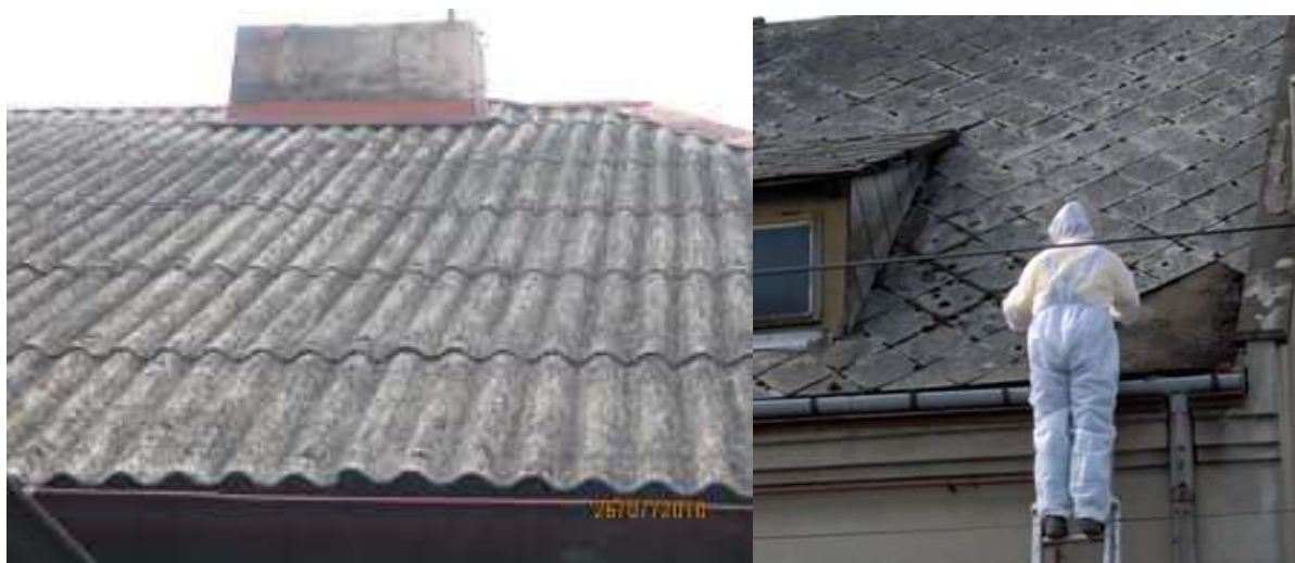
Ryc. 18. Rodzaje wyrobów zawierających azbest. Po lewej - płyty dachowe faliste (W02), po prawej - płyty azbestowo - cementowe typu „karo” (W01)
