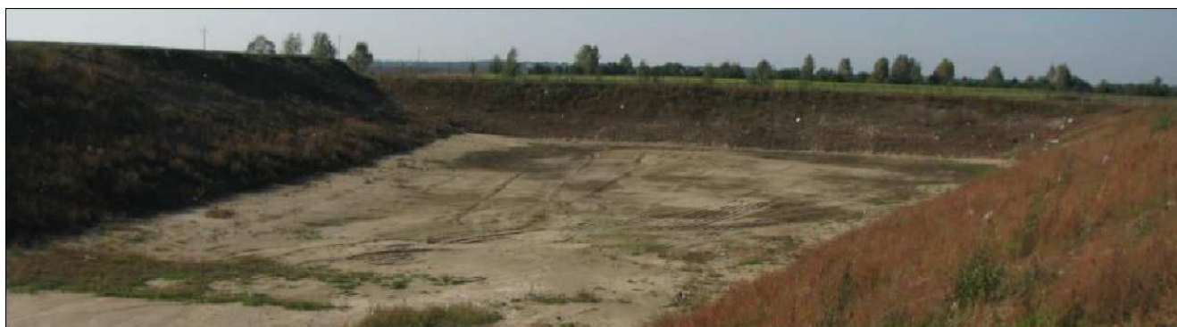
Kwaterna odpadów azbestowych (w budowie)
