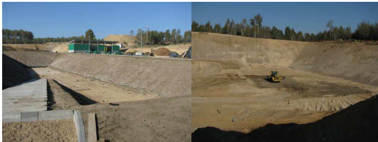
Ryc. 23. Zakład Przetwarzania i Unieszkodliwiania Odpadów w Czerwonym Borze - kwatery odpadów azbestowych (w budowie)
